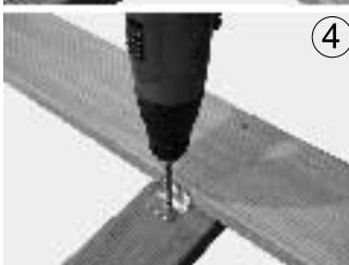
④ Die erste IGEL-Reihe verschrauben (max. 4Nm).
