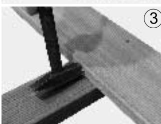
③ Erstes Brett einseitig mit Schrauben befestigen. Auf der gegenüberliegenden Seite die erste IGEL-Reihe mit dem Hammer einschlagen.
