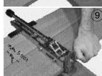
⑨ Das Verlegewerkzeug spannen. Die entstandene Fuge soll max. 5 mm betragen. Eventuell das Verlegewerkzeug in ungespanntem Zustand nachjustieren.
