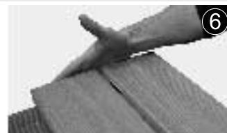
⑥ Das Brett am Ende bündig ausrichten.
