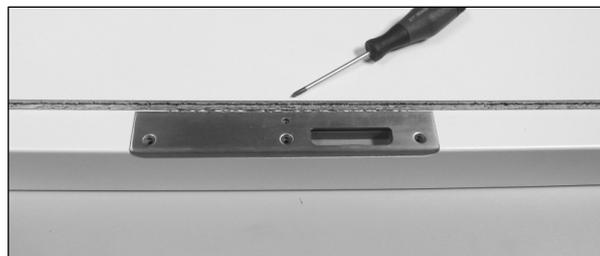
Schließblechwinkel auf die Kunststoffunterfütterung schrauben.
