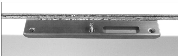
Schließblech zunächst auf der Vorderseite mit den Schrauben 3,5 x 25, ausgehend von der Mitte, festschrauben. Dabei auf korrekten Schließblechsitz achten.
