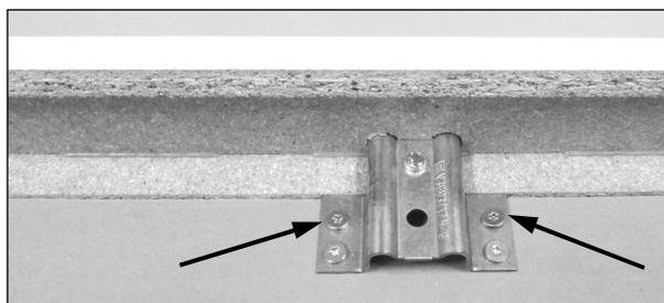
Abschließend die restlichen 4 Schrauben 4 x 20 in die freien Schraublöcher der Haltetaschen der Bandtaschen schrauben.
