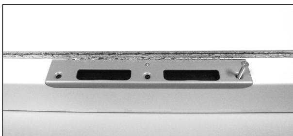
Dichtung herausziehen und die drei vorderen Schließblechschrauben 3,5 x 25 losschrauben.
