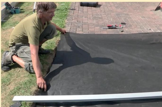
Um unerwünschten Pflanzenwuchs\* zu verhindern, empfehlen wir die Verwendung von Planex-Unkraut- und Wurzelvlies. Das Unkrautvlies wird einfach auf der fertigen Grundfläche der Terrasse ausgebreitet. Zudem dient das Unkrautvlies auch zur Entkoppelung zwischen einem PVC-Untergrund und unseren Gummigranulatunterlagen (Wechselwirkung / Weichmacherwanderung).
