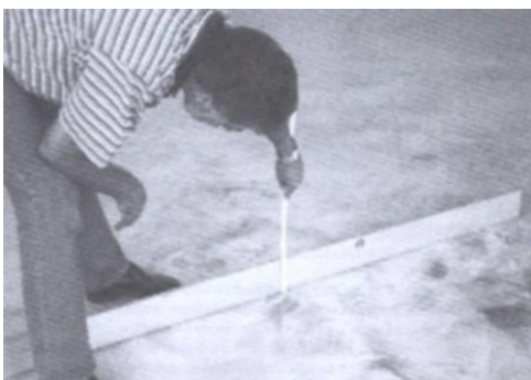
Abbildung 2 (Überprüfung der Ebenheitstoleranzen)
