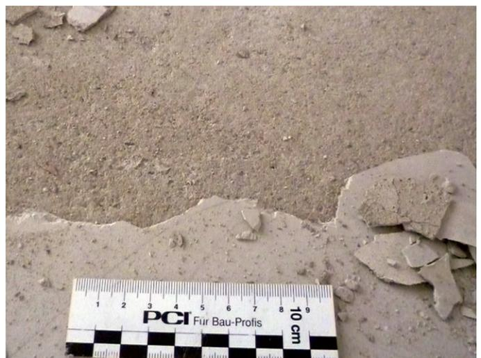
Abb. 2 – Abplatzung durch labile Randzone.
