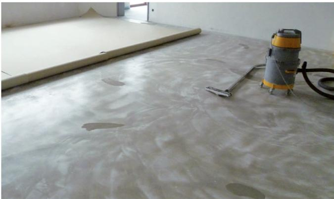
Abb. 7 – Geschliffene Spachtelmasse.
