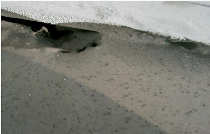
Abb. 3 – Fehlender Randdämmstreifen.
