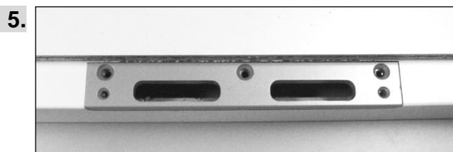
Zargenteil drehen, das Schließblech auflegen, ausrichten, dicht an die Fräskanten drücken und mit Hilfe der Schraublöcher den richtigen Sitz der Schließblechhalteplatte überprüfen. Ggf. den Sitz der Schließblechhalteplatte korrigieren.
