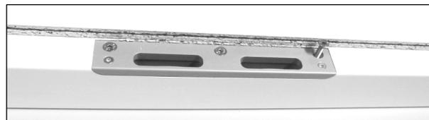
Danach das Schließblech mit den Schrauben M 5 x 20 mit der rückseitigen Halteplatte verschrauben und die Dichtung wieder einziehen.
