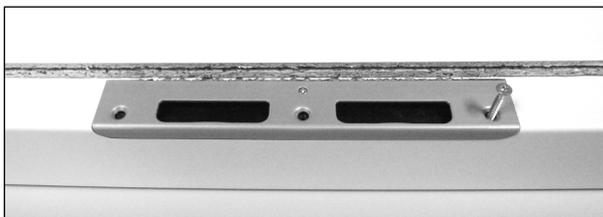
Dichtung herausziehen und die drei vorderen Schließblechschrauben 3,5 x 25 losschrauben.
