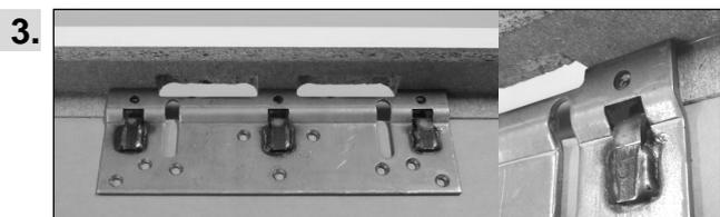
Die Schließblechhalteplatte von der Zargenrückseite einsetzen und bis an die Bekleidung schieben.
