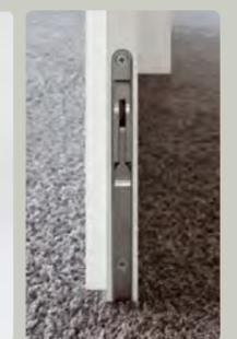
Bodenverriegelung des Standflügels
