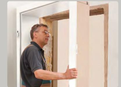
Die Tapete wird um die Bekleidung herum sauber eingeschnitten. Mit einem Stecheisen wird die Zierbekleidung von der Zarge gedrückt und das Futterbrett der Zarge im unteren Drittel mit einem sauberen Schnitt durchgesägt. Danach lässt sich die Zarge problemlos ausbauen. Bei der gesamten Demontage fällt kein nennenswerter Schmutz an, da keine Stemmarbeiten oder Ähnliches erforderlich sind.
