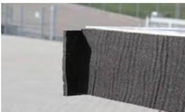
3. Stoßen Sie die Eckverbindungen stumpf. Seitlich sollte das **beko Fugendichtband** entsprechend der lichten Öffnung überstehen. Stoßen Sie das **beko Fugendichtband** am oberen Rahmen bündig an die seitlichen **beko Fugendichtbänder** an.
