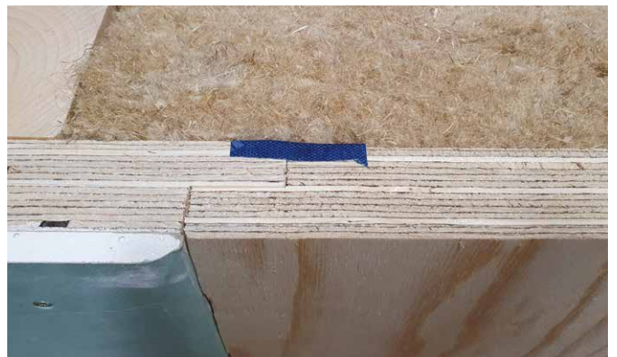
Abgeklebte Stufenfalzplatte mit Dämmung.
