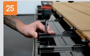
Das Unterteil des Terrastarts am Ende der Schiene mit der Bohrschraube aufschrauben (3 mm vorbohren). Die Diele wird zunächst mit der zur bereits verlegten Fläche zeigenden Nut auf den Terraflex geschoben.
