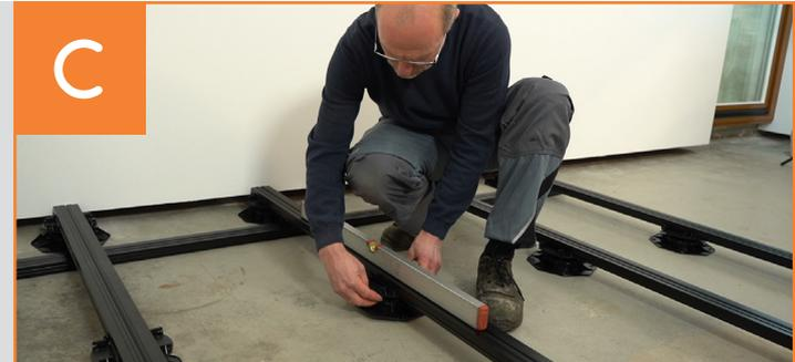
Unterkonstruktion ausrichten und mit Konterlattung und Lagern verschrauben
