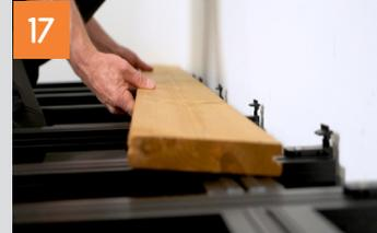
Befestigungsclip des Terrastarts bis zur ersten Arretierung in die Nut des Unterteils stecken. Terrassendiele auf das Unterteil des Terrastarts legen und auf der anderen Längsseite den Terraflex einsetzen. Dann den Befestigungsclip des Terrastarts durch Andrücken in das Unterteil einrasten lassen.
