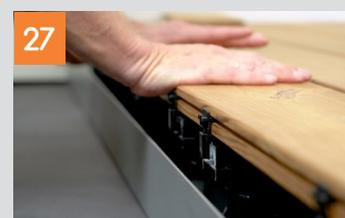
Danach wird der Befestigungsclip des Terrastarts in die Nut der Diele geführt und mit der Diele zusammen von oben in das Unterteil eingesteckt. Nach Einsetzen aller Befestigungsclips kann die Diele nun fest arretiert werden.
