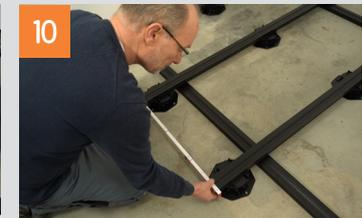
Jetzt kann die Konstruktion in Längs- und Querrichtung ausgerichtet werden.
