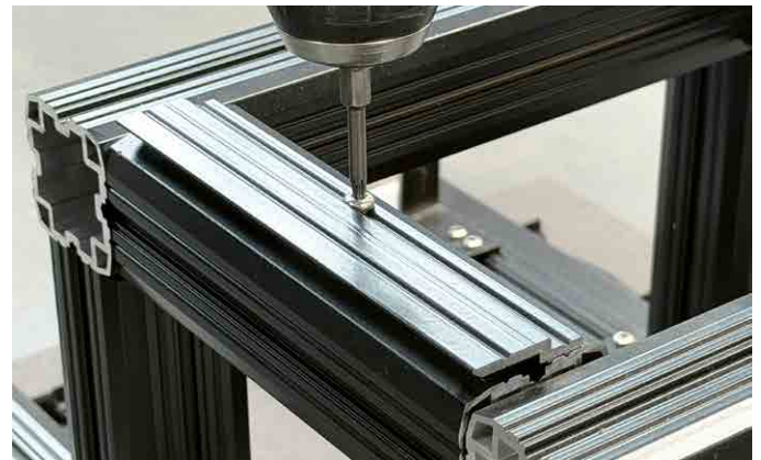
Z-Profil auf der Aluminium-Unterkonstruktion positionieren und befestigen.
