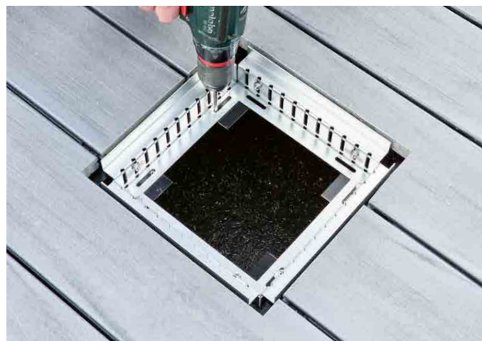
Revisionskasten einsetzen und an Windlastträger verschrauben.
