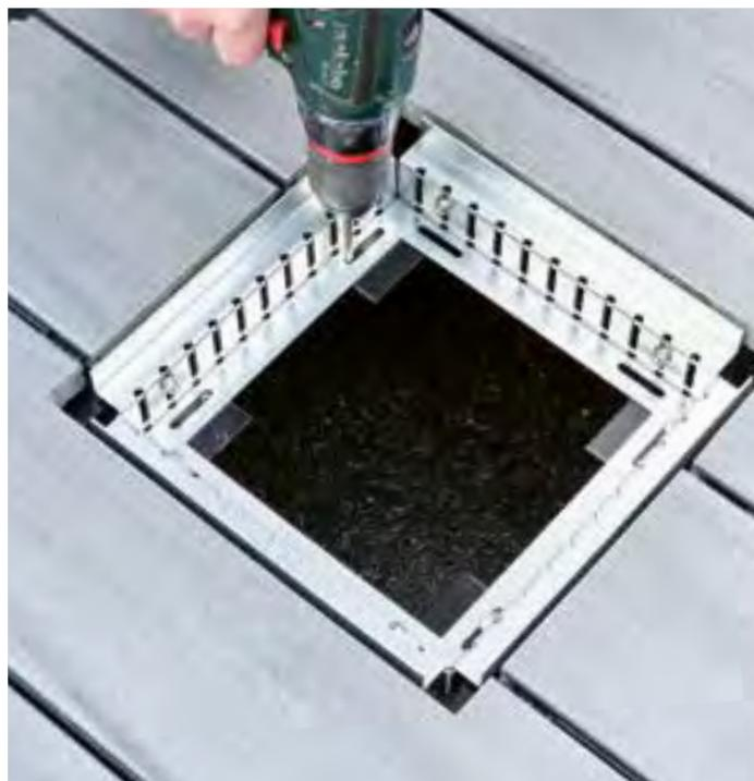
Revisionskasten einsetzen und an Windlastträger verschrauben
