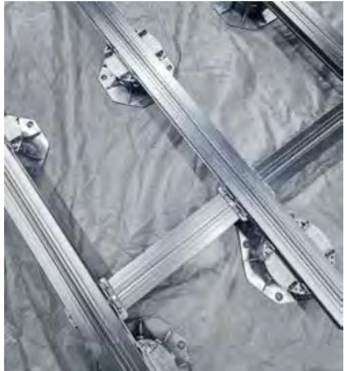
Konstruktion mit Verschraubung auf dem Boden
