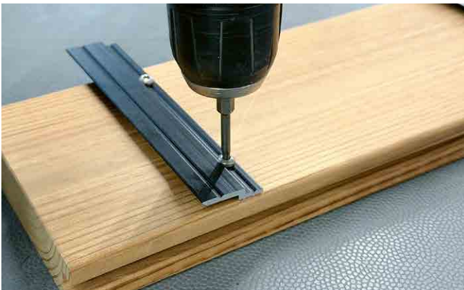
Z-Profil an der Deckbelag-Unterseite ausrichten und verschrauben.
