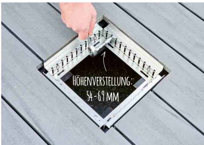
Höhe des Revisionskastens an den Terrassenbelag anpassen.
