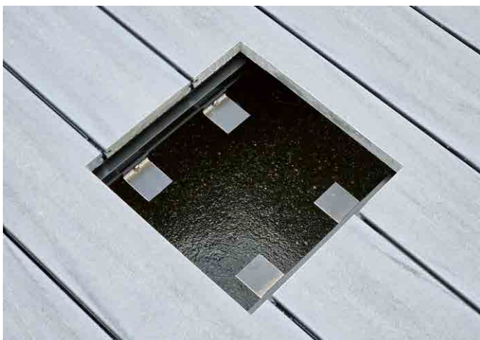
Windlastträger (Art.-Nr. 7517) an der Aluminium-Unterkonstruktion befestigen.
