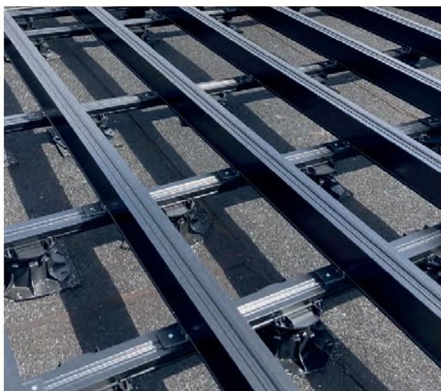
Unterkonstruktion mit Isostep-System
