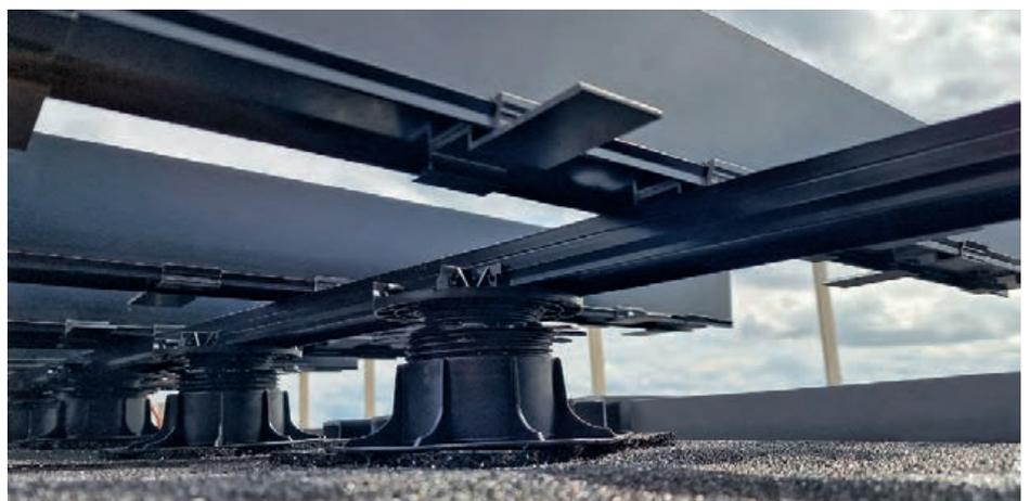
Beschwerung des Systems z. B. durch Beton- oder Stahl-Platten 30x30 cm auf das geforderte Flächengewicht.
