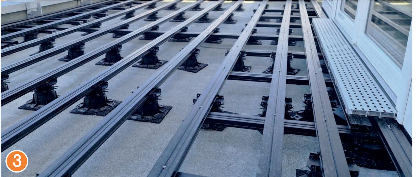
Dachterrasse/Laubengang auf Gefälledämmung mit Abdichtung
