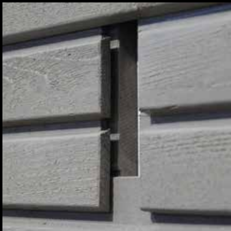
Stirnseitige Nut und Feder bei horizontaler Verlegung
