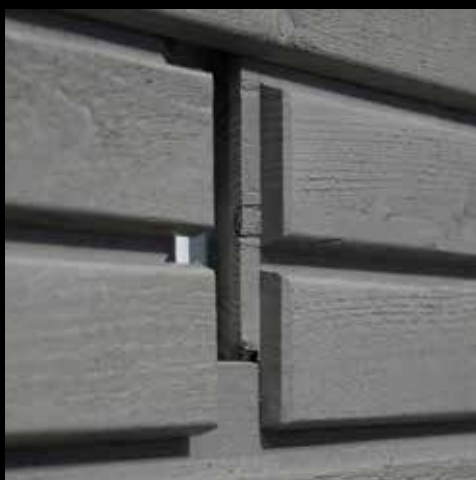
Tropfkante 15° oder 30° bei vertikaler Verlegung
