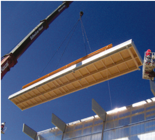
Abb. 4.9: Montage Dachelement einer Industriehalle
