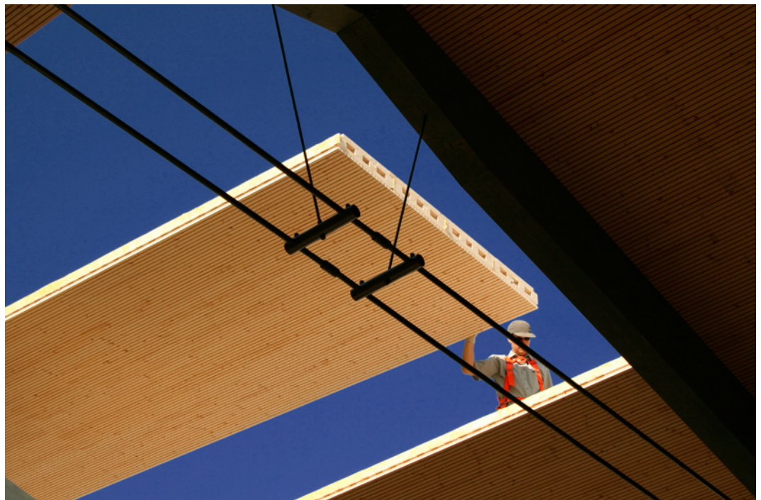
Abb. 4.2: Montage Massivholzelement (Gemeindehalle Kadelburg, Architekturbüro Reichmann, Waldshut-Tiengen)
