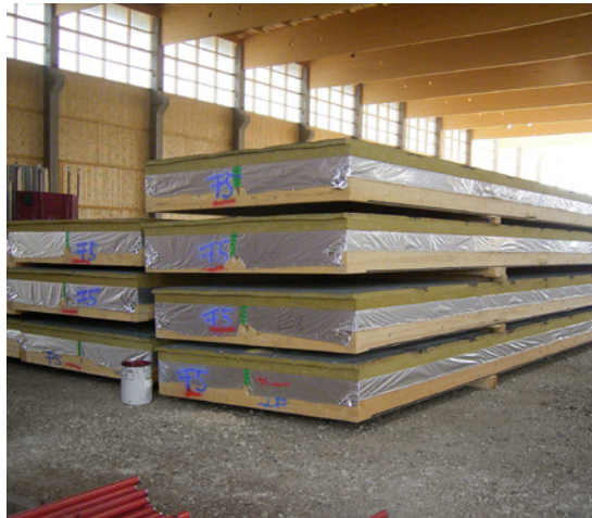
Abb. 4.10: Zwischenlagerung der Dachelemente
