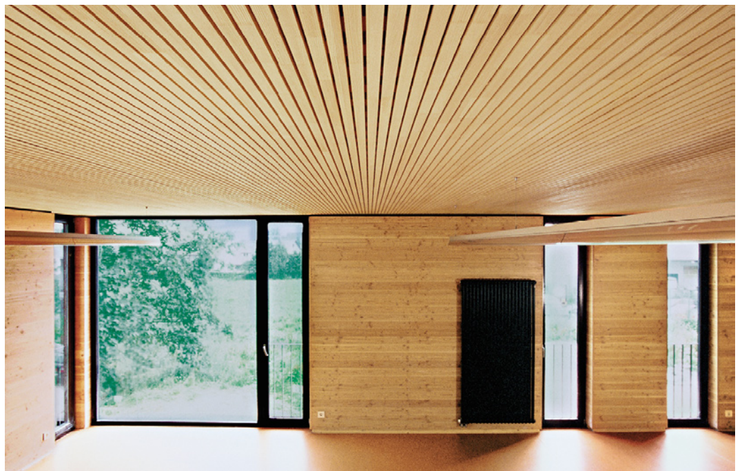
Abb. 4.6: Tragende Akustikdecke mit Elementuntersicht in astreinem Weißtannenholz (Kinderhaus Ludwigsburg, Dip.-Ing. Freier Architekt BDA Kai Dongus, Ludwigsburg)
