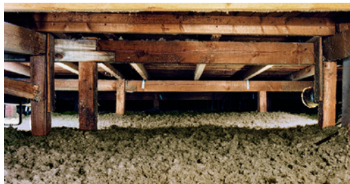
Abb. 3.8: Belüftetes Flachdach, gleichmäßig gedämmt mit Steinwollegranulat
