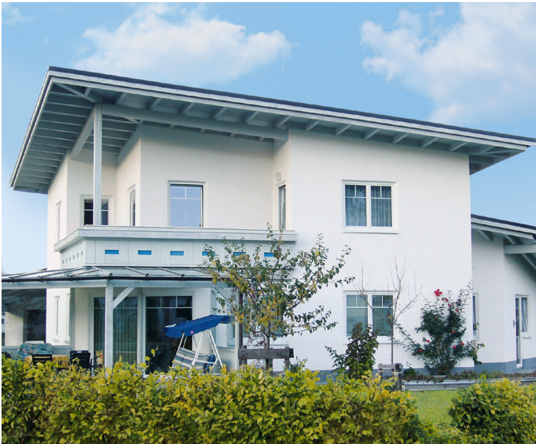
Abb. 1: Einfamilienhaus mit Holzfaser-WDVS
