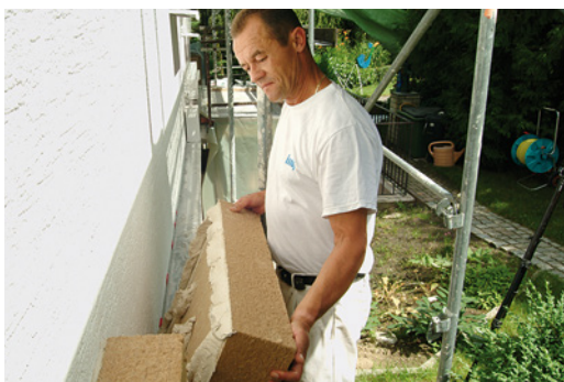
Abb. 13: Konstruktive Verklebung von Holzfaser-WDVS im Punkt-Wulst-Verfahren
