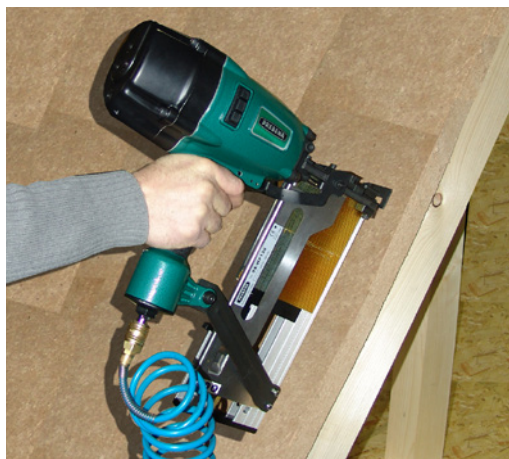
Abb. 10 und 11: Befestigung von Holzfaserdämmplatten auf Holzkonstruktionen
