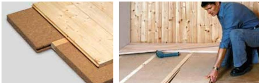
kommen auch Decken, welche die Empfehlungen für normalen oder erhöhten Schallschutz in Einfamilienhäusern erfüllen sollen. Wie bei den sichtbaren Holzbalkendecken werden auch hier deutliche Verbesserungen des Schallschutzes durch das Aufbringen biegeweicher Beschwerungslagen erzielt. Eine Senkung des Normtrittschallpegels um bis zu 15 dB ist möglich [45].
