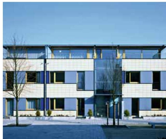
Im zurückspringenden Dachgeschossbereich und auf den Gartenseiten ist die Außenhaut mit Holzfensterelementen aus lasierter Kiefer ausgeführt. Die Balkonelemente sind im 1. Obergeschoss auf den Gartenseiten vor die Baukörper gestellt. Ihre Stahlkonstruktion ist vom Kerngebäude thermisch entkoppelt. Für den Gehbelag wurden profilierte Holzplanken verwendet.
