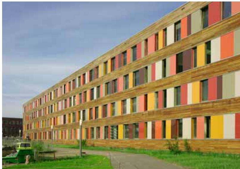
– Äußere Bekleidung aus Lärchenholz auf Unterkonstruktion im Brüstungsbereich, ESG-Bekleidung, Fensterbank und Sturzblech aus verzinnem Kupfer.
