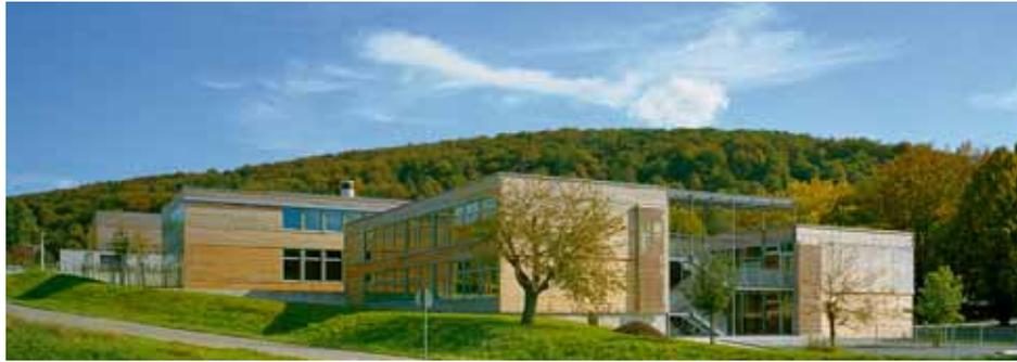
Ein Beispiel für voll auf die Holztafeln aufgelegte Betondecken ist die Lohrtalschule in Mosbach. Hier sind sowohl die tragenden Innen- als auch die ebenfalls tragenden Außenwände in Brettstapelbauweise ausgeführt, während – im Wesentlichen zur Stabilisierung des Raumklimas – die Geschossdecken aus Ortbeton hergestellt wurden.
