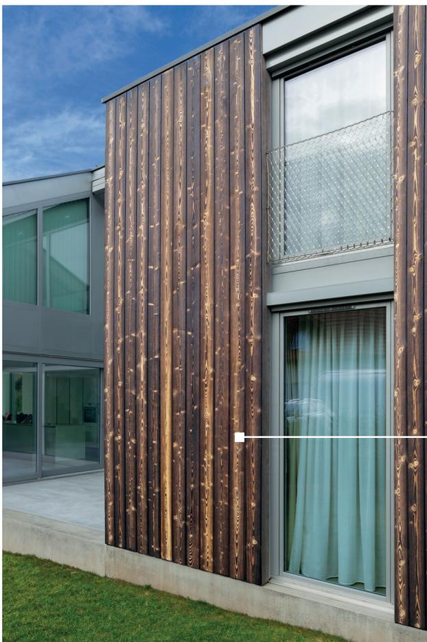
**Holzoberflächen mit Charakter für außen.** Durch leichte Beflammung behält die Oberfläche der Holzprofile ihre charakteristische Maserstruktur. Sie wird sogar noch deutlicher herausgezeichnet, da sich die weicheren und härteren Holzanteile unterschiedlich stark karbonisieren und verfärben. Eine Individualität, die durch die Wahl der Holzart und durch die Wahl der Oberflächenbearbeitung mehr Vielfalt bietet.
