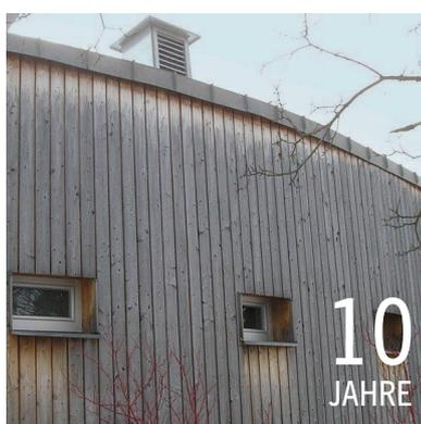
Die natürliche Vergrauung erfolgt nicht einheitlich, da sie je nach Lage der Bauteile unterschiedlich lange dauert. So verwittern Teilbereiche unter Vordächern, Fensterbänken oder Gebäudevorsprüngen deutlich langsamer und heterogener.
